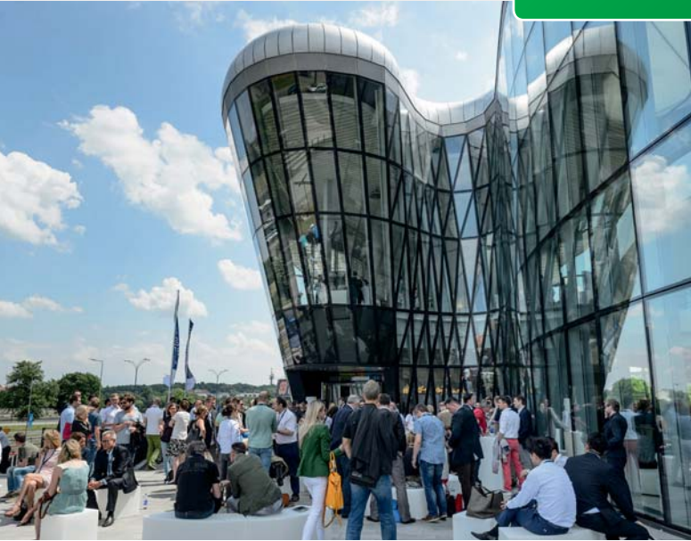
Das International Conference and Entertainment Center – ICE – in Krakau beeindruckt durch seine moderne Architektur und technische Ausstattung.
